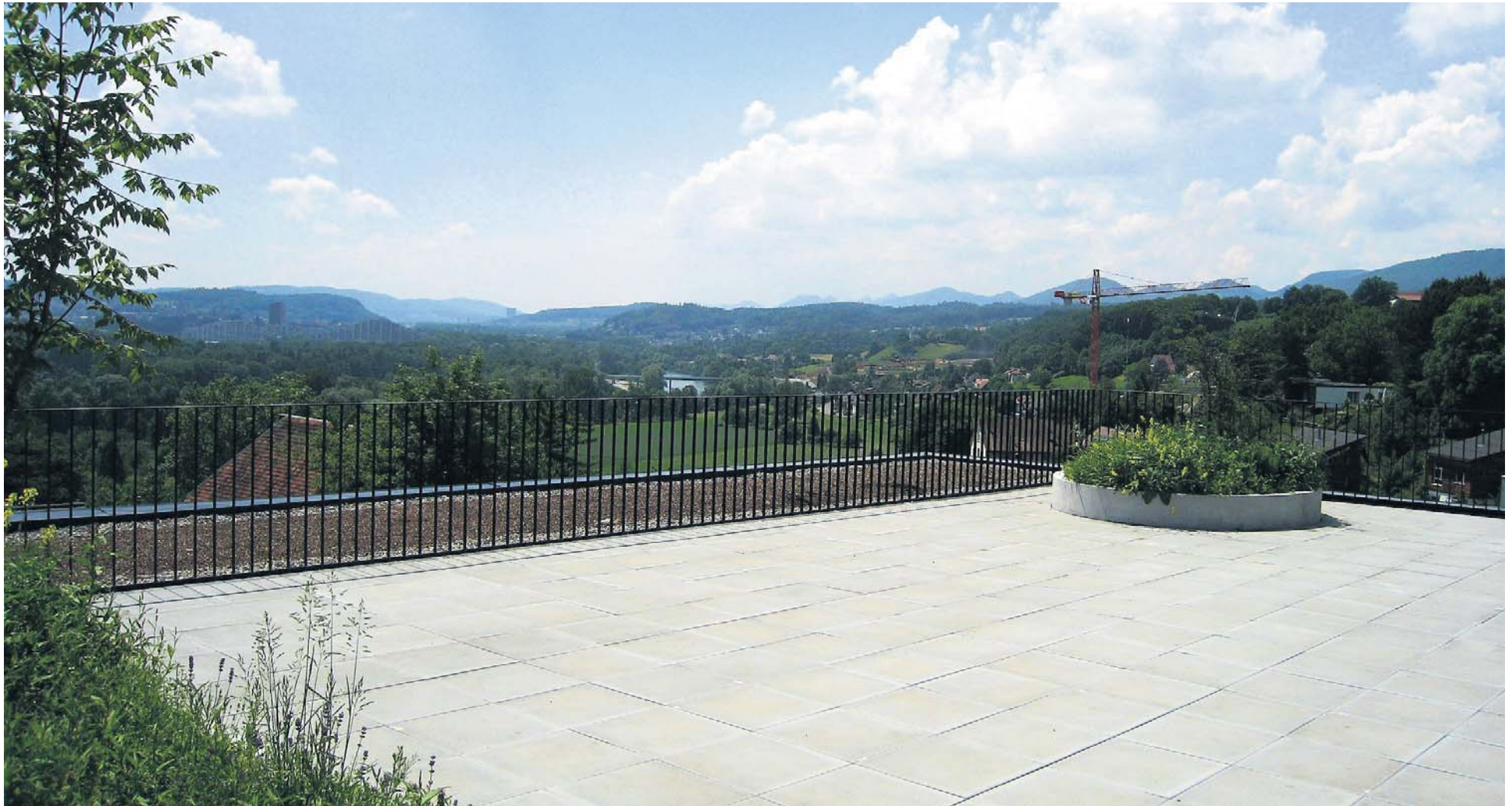
Terrassenhausüberbauung, «Gislifuhweg» Biberstein – gebaut 2007
